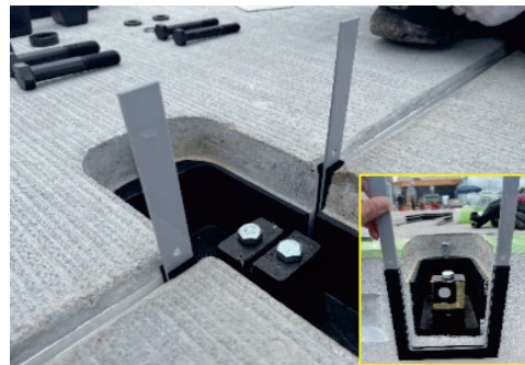
写真-3 目地養生材設置状況
