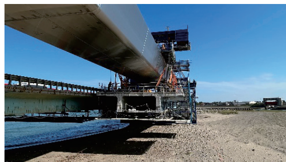
写真-1 吊下げ撤去状況
