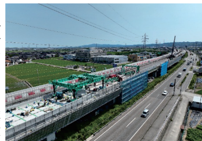
写真-1 床版架設全景
