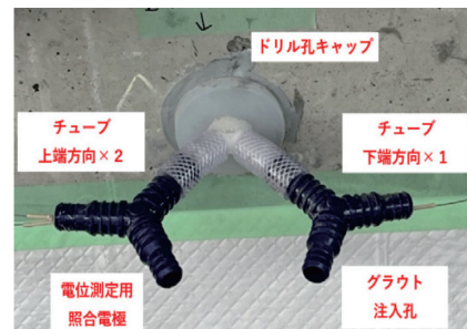
写真-2 1孔式ドリルキャップ取付状況
