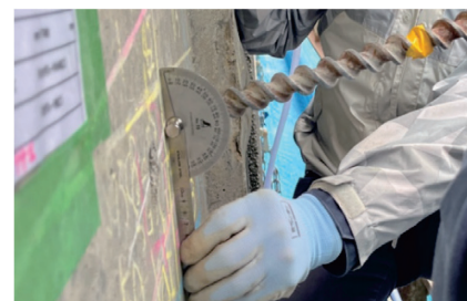
写真-1 斜め削孔状況
