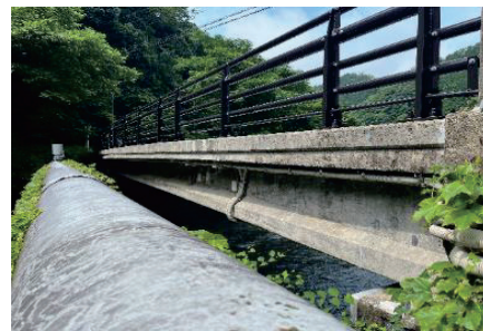
写真-1 橋梁外観
