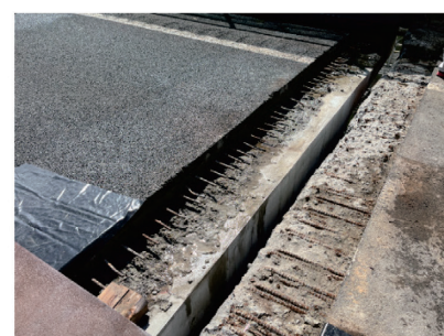
写真-2 断面修復完了後
