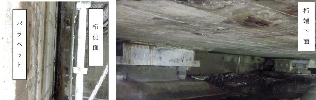
写真-1 桁端部塩害劣化状況 (左：桁側面 右：下面)
