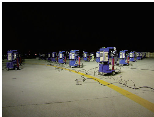
写真-1 リフトアップ工法の施工状況
