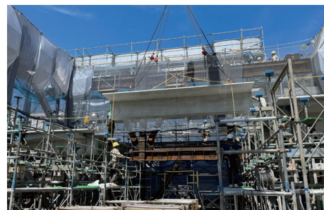
写真-3 部材架設状況
