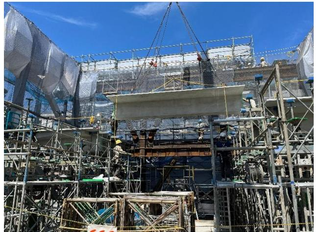
写真-6 部材架設状況
