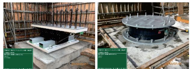
写真-2 免震装置設置状況
