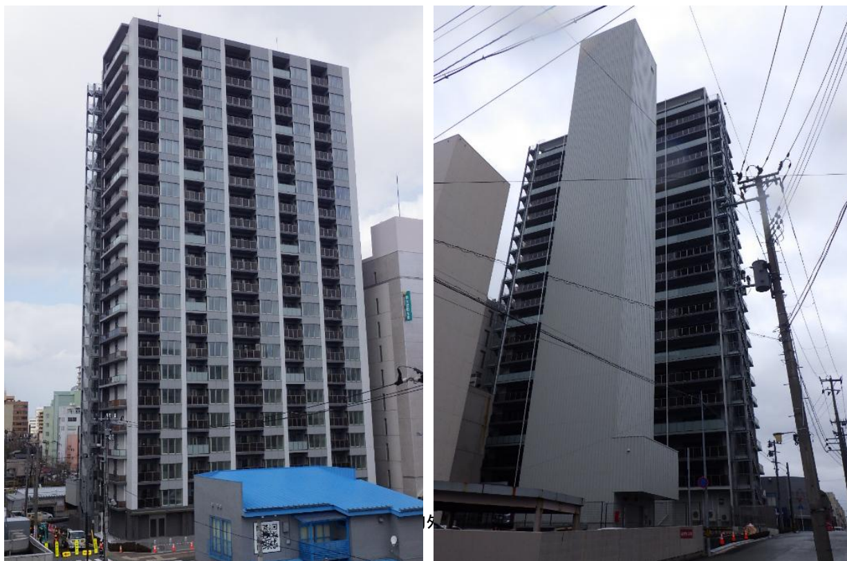
写真-1 建物外観
