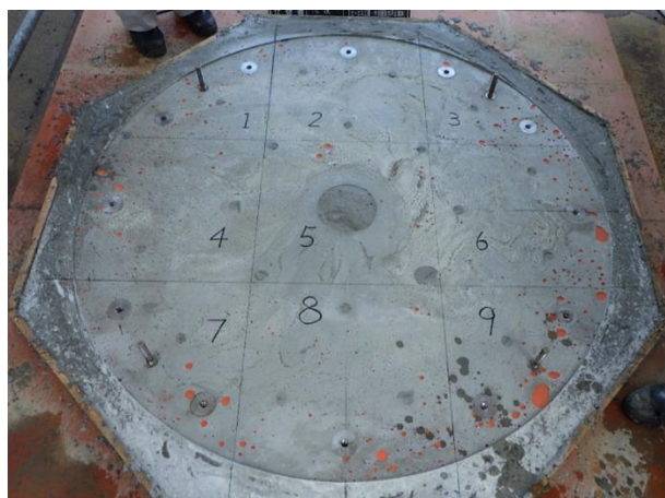
写真-4 ベースプレート取外し後
