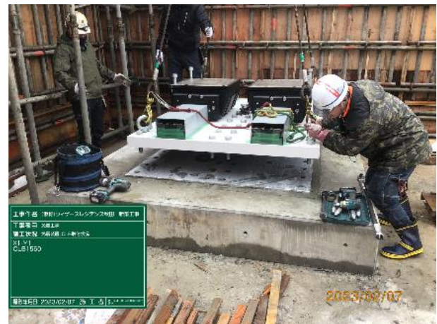
写真-3 直動転がり支承設置状況
