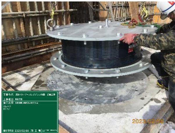
写真-2 高減衰ゴム系積層ゴム設置状況
