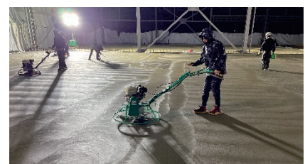
写真-2 倉庫床鏡面仕上げ
