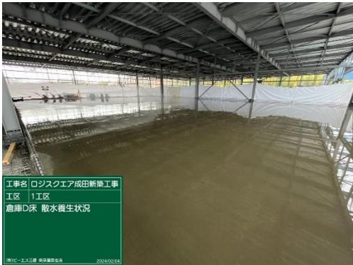
写真-6 散水養生状況 (1日目)
