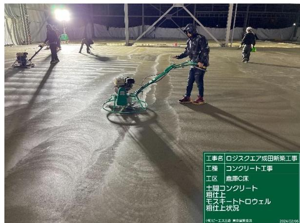
写真-5 土間押さえ（鏡面仕上げ状況）
