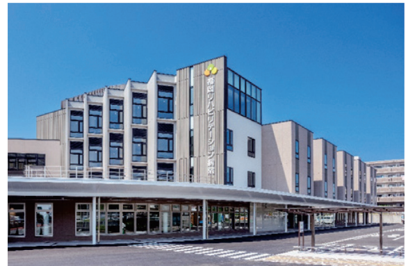
写真-1 建物外観
