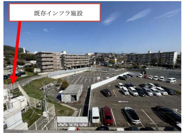
写真-3 着工前状況（手前側が既存病棟）
