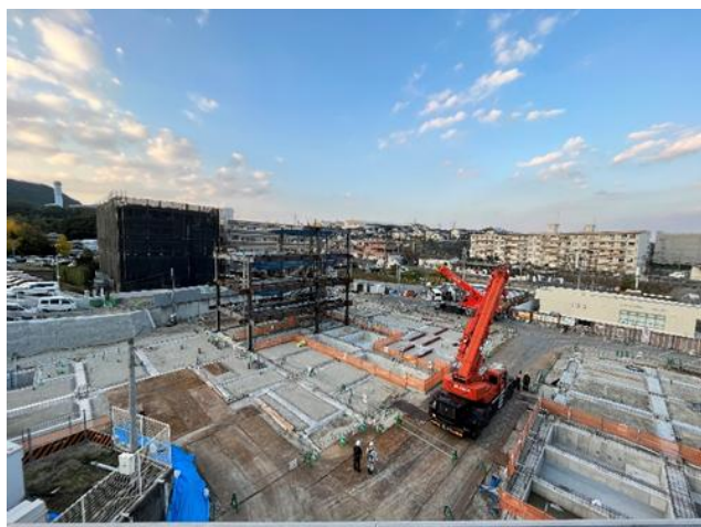
写真-6 工事状況 A 工区（鉄骨工事）
