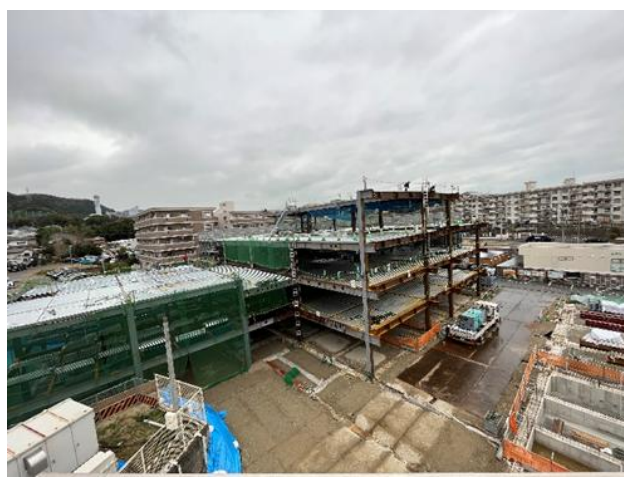
写真-7 工事状況 D 工区（鉄骨工事）
