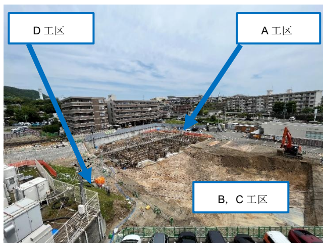
写真-4 工事状況
