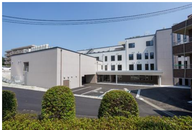
写真-2 建物外観（南側）
