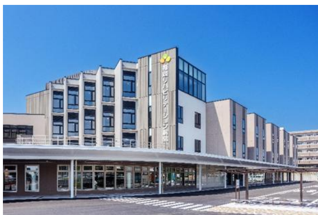
写真-1 建物外観（東側）
