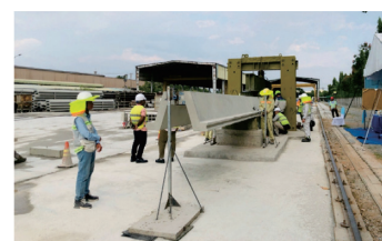
写真-4 曲げ耐力試験 状況
