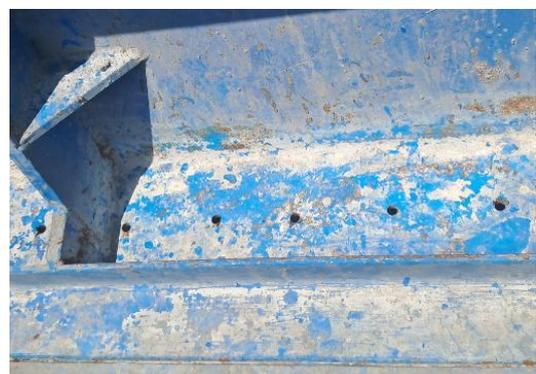
写真-13 型枠に設けた残留気泡排出孔
