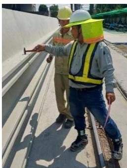
写真-25 打音検査
