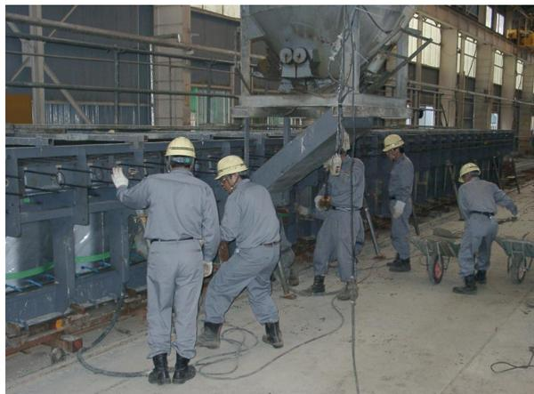
写真-14 コンクリート打設状況
