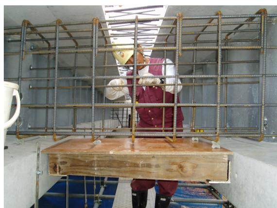
写真-25 横桁鉄筋組立状況
