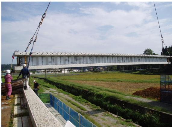
写真-22 主桁架設状況
