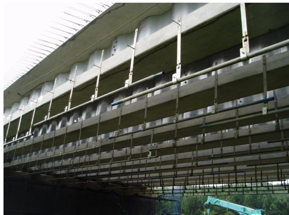
写真-23 主桁架設完了状況
