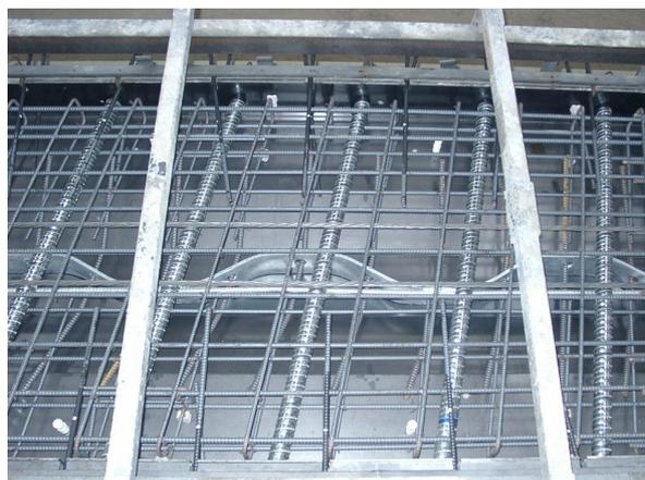
写真-12 上フランジ型枠と波形鋼板
