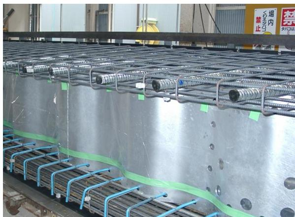
写真-11 波形鋼板組立状況
