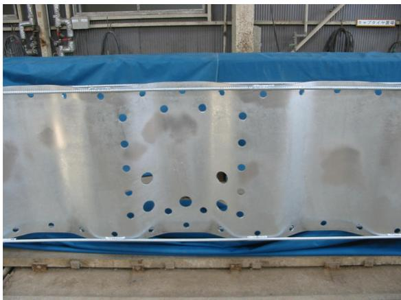
写真-6 横桁部の孔
