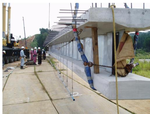
写真-18 架設時の支点部補強
