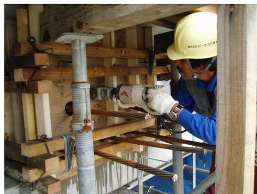
写真-19 横桁CON締固め状況
