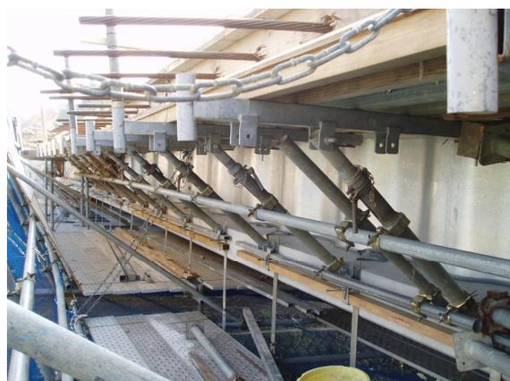
写真-26 シース・PC鋼材組立状況
