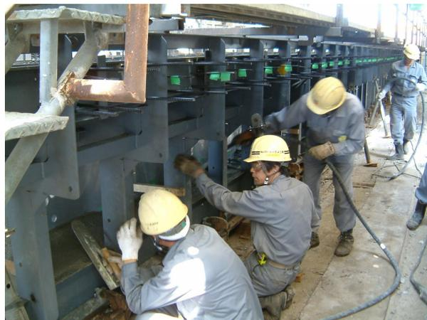
写真-15 下フランジ天端仕上げ状況
