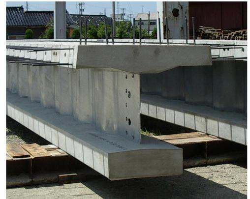
写真-1 曾宇川橋主桁断面
