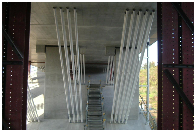
写真-3 仮設斜材設置状況
