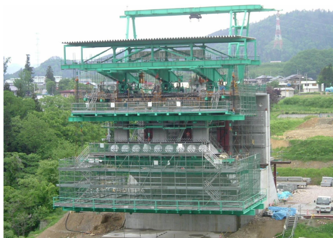
写真-2 2層式移動作業車
