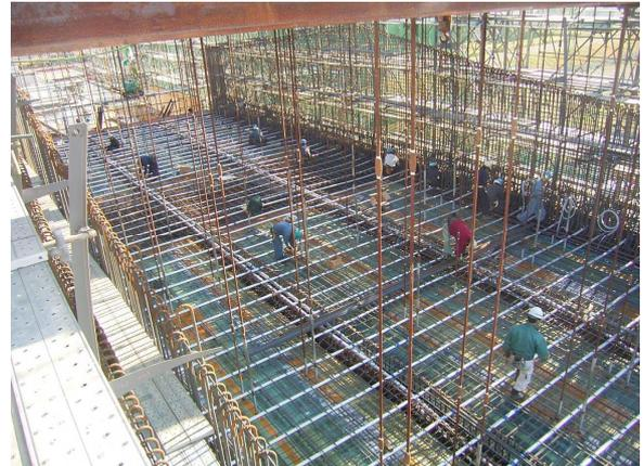
写真-7 横締めケーブル配置状況
