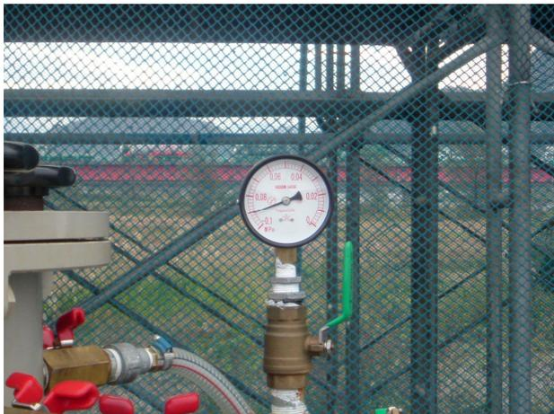
写真-21 デカンタの負圧測定圧力計
