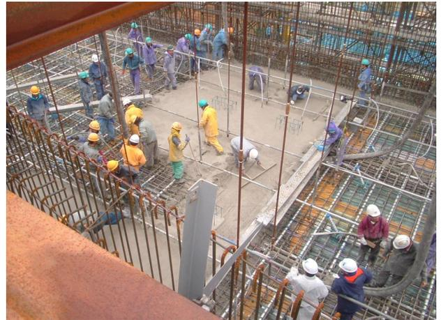
写真-12 箱桁部コンクリート打設状況
