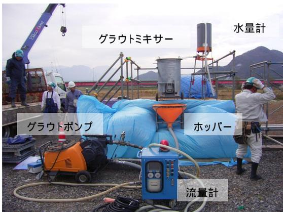
写真-19 練混ぜおよび注入設備
