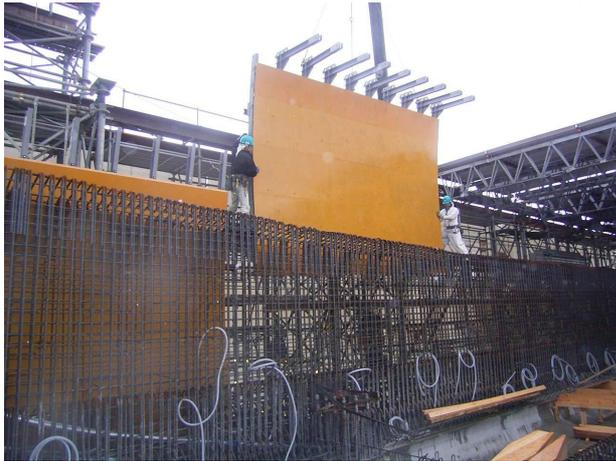
写真-4 フィン部側枠組立状況
