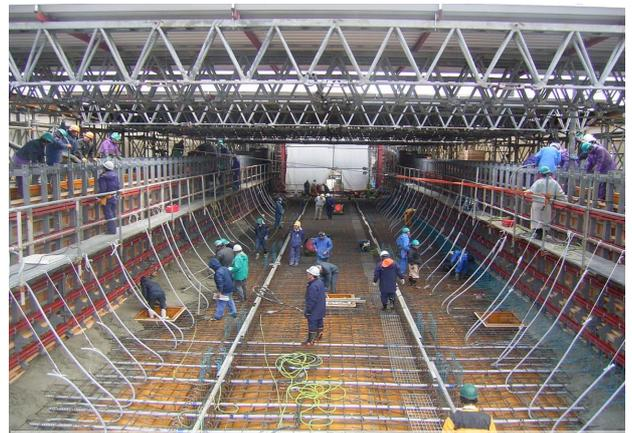
写真-13 フィン部コンクリート打設状況
