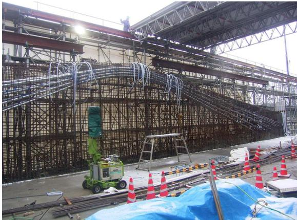
写真-6 フィン部主ケーブル配置状況
