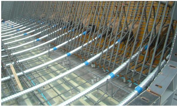
写真-9 横締めケーブル配置状況
