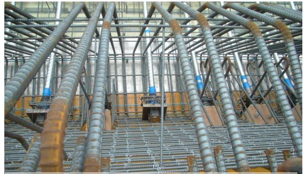
写真-10 デッドアンカー配置状況
