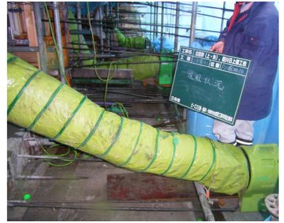
写真-17 箱桁内送風状況
