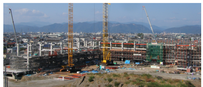
写真-5 PC 工事状況
