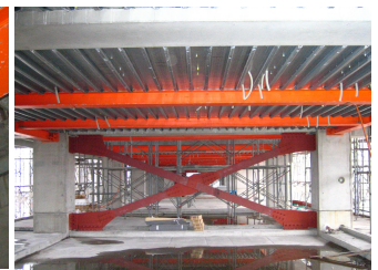
写真-2 S プレースの設置状況
