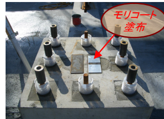
写真-3 PCaPC 柱天端状況
