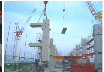
写真-4 柱架設状況
