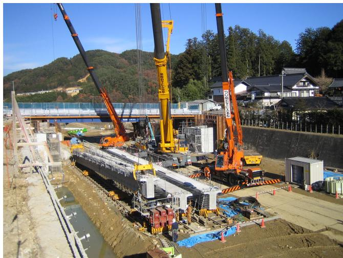
写真-1 主桁架設状況
