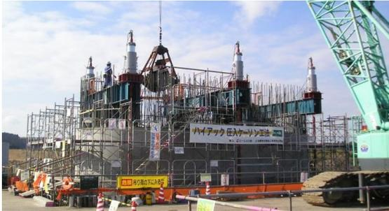
写真-2 圧入掘削状況
