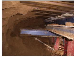
写真-4 拡幅部掘削
