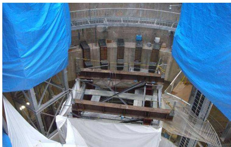
写真-6 作業構台施工状況
