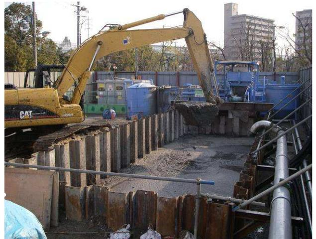
写真-11 土砂ピット設備
