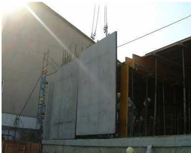
写真-11 妻壁ハーフ PCa 部材架設状況
