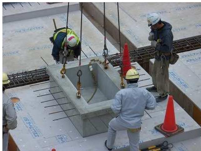
写真-4 床下収納PCa部材
