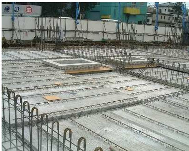
写真-3 1階床ハーフPCa板
