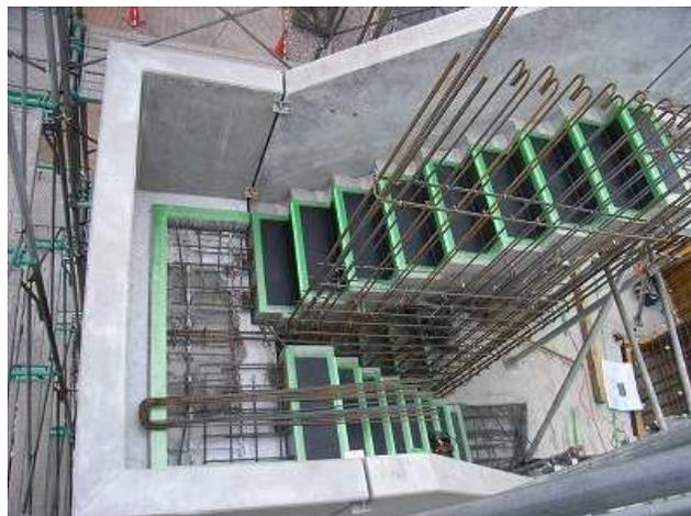
写真-10 外部階段 PCa 部材
