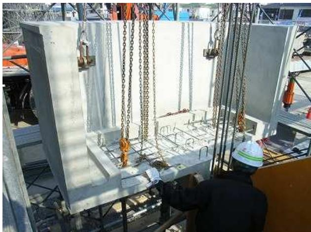
写真-9 外部階段 (中踊場) PCa 部材
