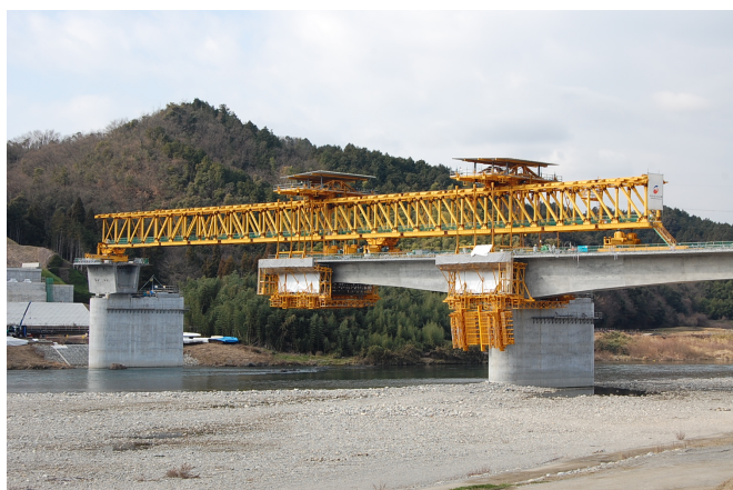
写真-3 径間移動工 施工状況
