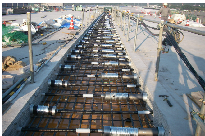
写真-5 連結床版工 施工状況
