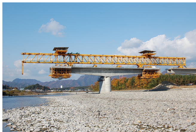
写真-1 P&amp;Z 架設装置
