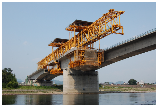
写真-2 外回り線施工状況
