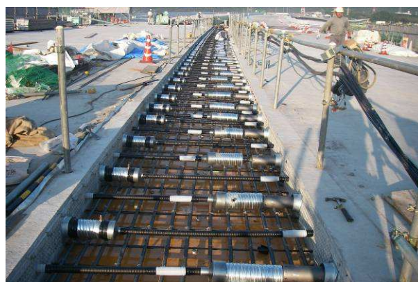
写真-18 連結床版工 施工状況
