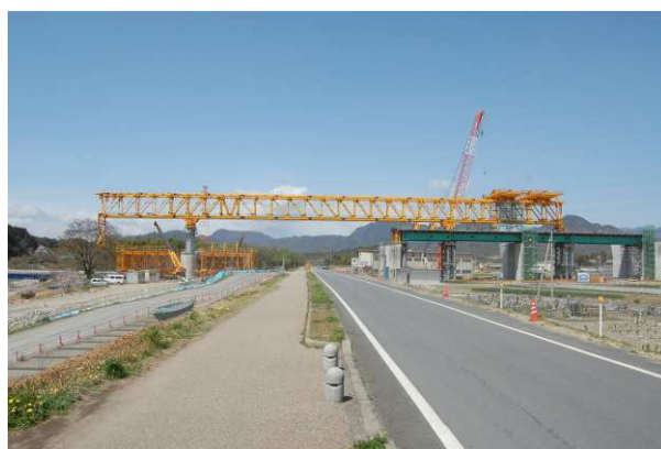
写真－2 架設桁送り出し完了状況
