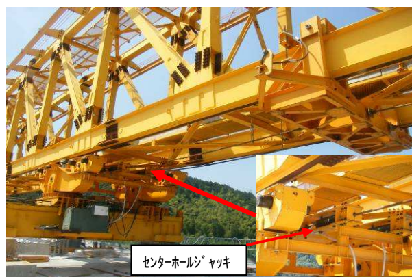
写真－6 ジャッキ牽引装置
