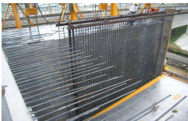
写真-14 ウェブ鉄筋ユニット吊り込み状況
