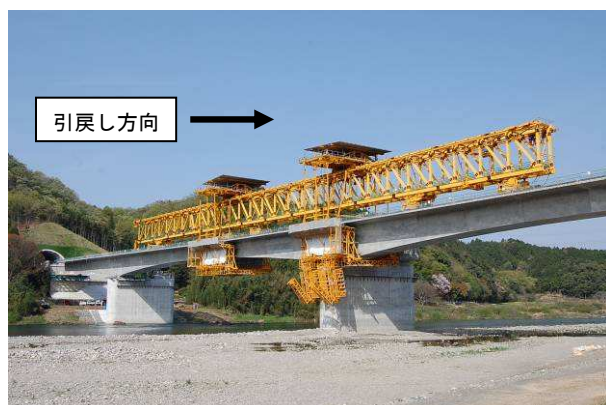
写真－5 架設桁引き戻し 施工状況
