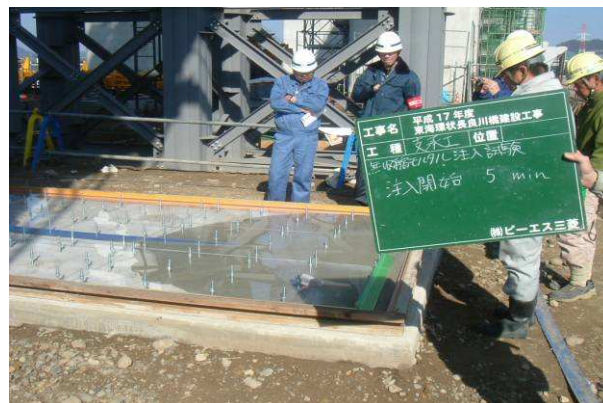
写真-9 実物大模型充填確認試験状況
