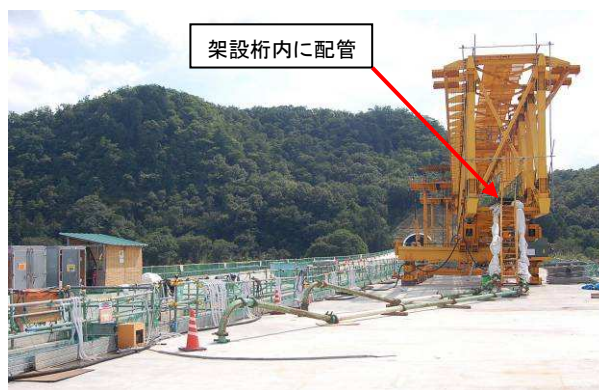
写真-15 コンクリート配管状況
