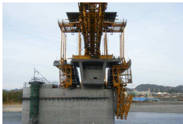
写真－4 橋脚通過時 開閉状況
