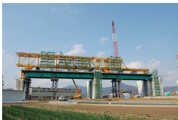
写真－1 架設桁組立構台と組立状況
