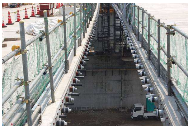
写真-17 張出施工完了時状況
