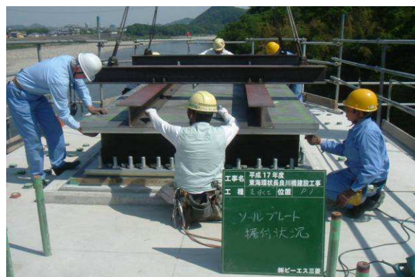
写真-10 支承据付状況
