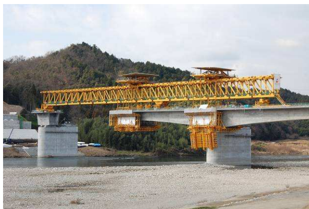
写真－3 径間移動施工状況
