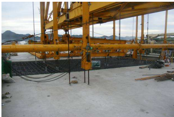
写真－16 閉合部打設前状況
