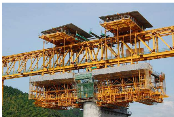
写真-13 P2 柱頭部施工状況
