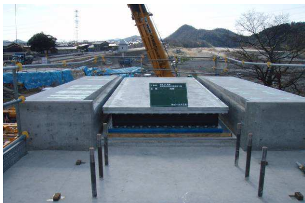
写真－11 仮支承・本支承施工完了(P3 橋脚)
