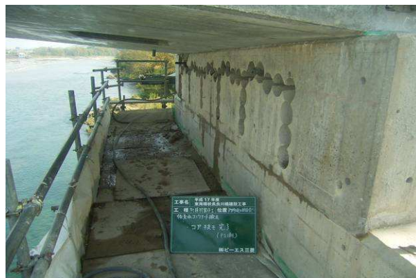
写真－12 仮支承コアボーリング完了状況
