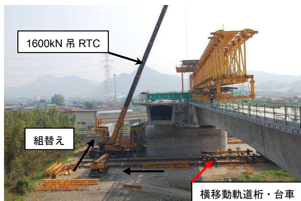
写真－7 吊り型枠横移動・組替施工状況
