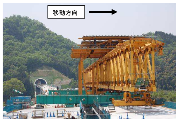
写真－8 架設桁横移動 完了状況
