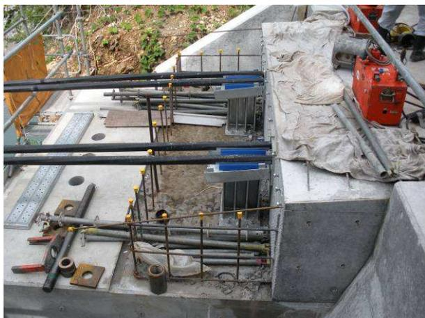
写真-4 第1外ケーブルの鉛直偏向部
