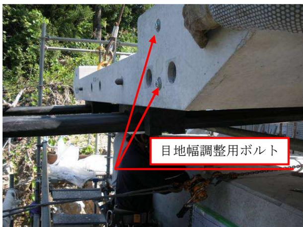
写真-6 目地幅調整用ボルト
