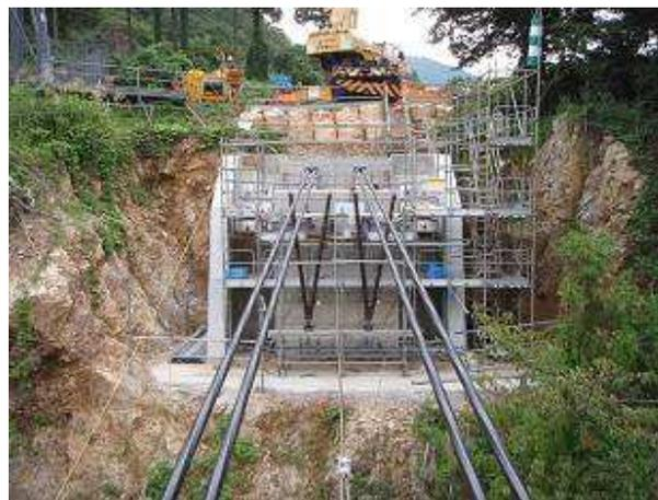
写真-5 鉛直材の設置
