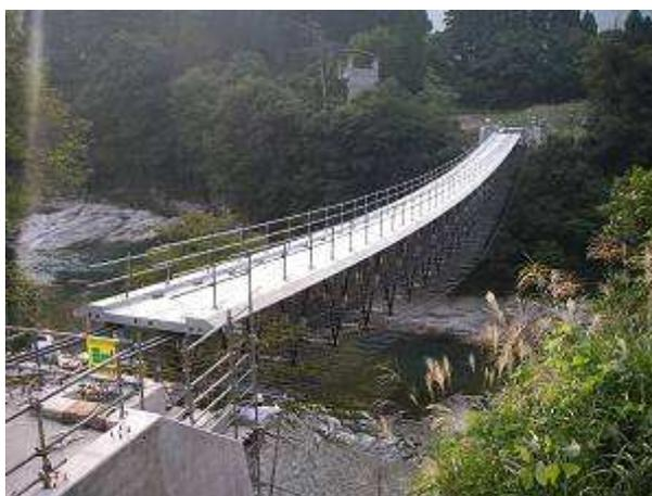
写真-9 プレキャスト版架設完了
