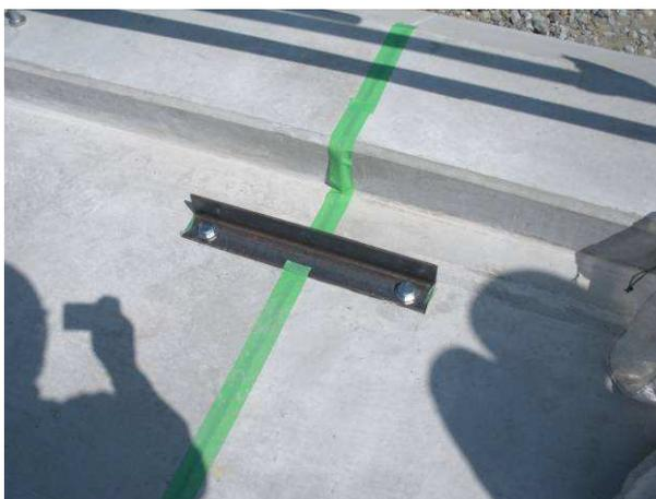
写真-7 プレキャスト版縦ずれ防止用連結金具
