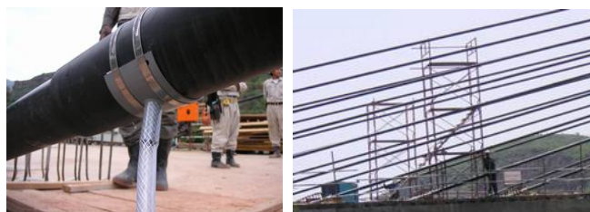
写真-7, 8 注入治具と分割注入用足場
