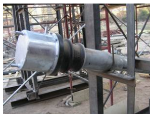
写真-2, 3 ケーシングパイプと架台
