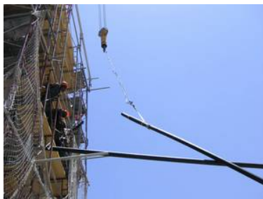
写真-5 PE 管の架設状況
