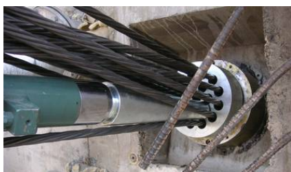
写真-6 斜材緊張状況
