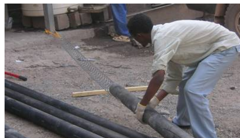
写真-4 スペーサーの組込み状況
