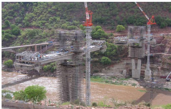
写真-1 施工状況
