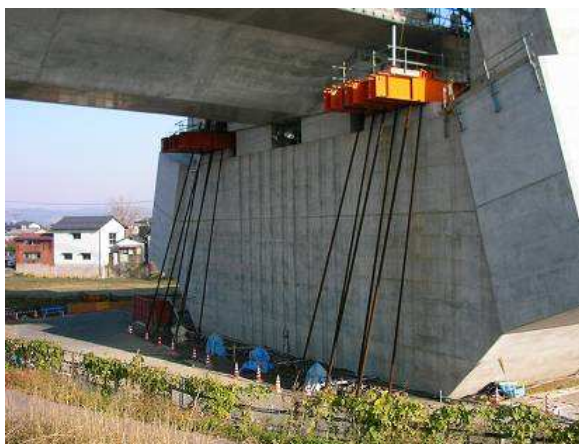
写真-19 グラウンドアンカー載荷工法
