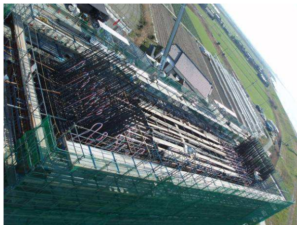
写真-1 脚頭部の施工
