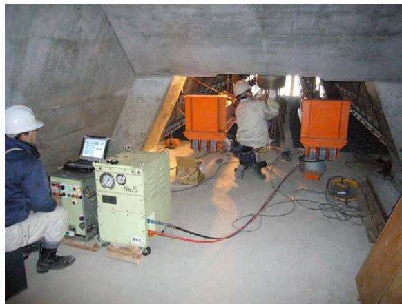
写真－12 斜材の緊張状況（主桁側）
