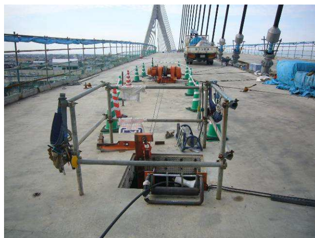
写真-13 外ケーブルの架設状況
