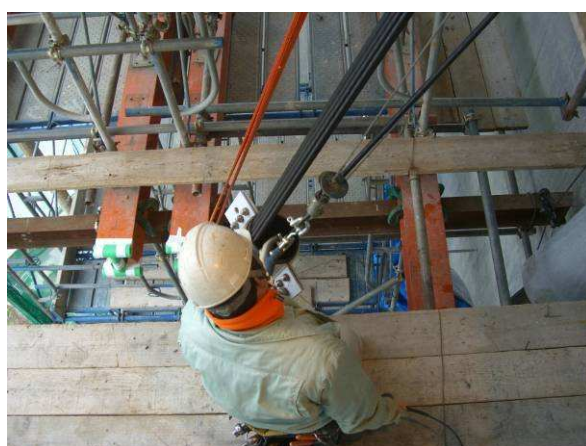
写真－11 斜材の架設状況（主塔側）
