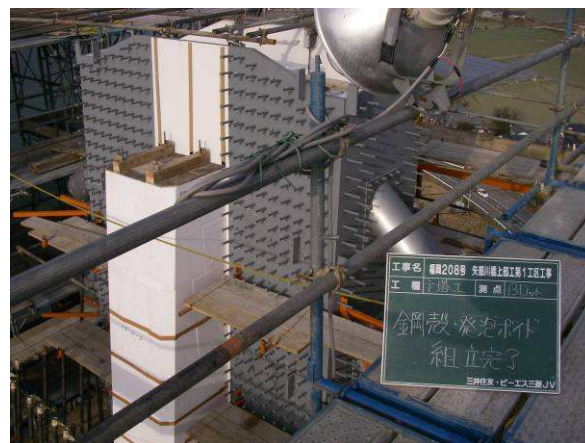
写真－5 主塔鋼殻の設置
