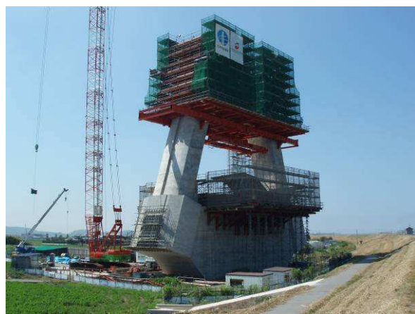
写真－3 SSUP の施工状況
