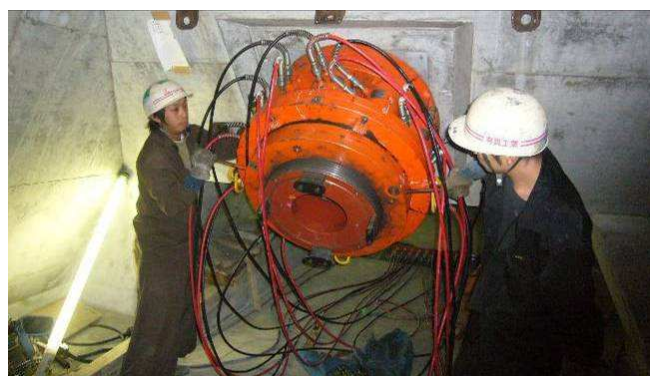
写真－15 斜材張力調整状況
