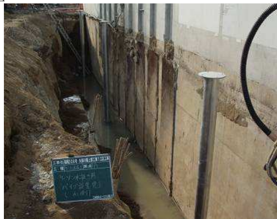
写真-21 ケーソン水抜き孔設置
