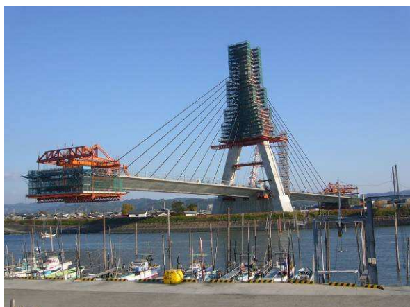
写真-7 超大型ワーゲン施工
