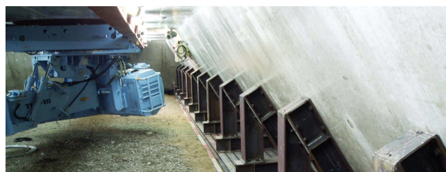
写真－16 過沈下防止金物
