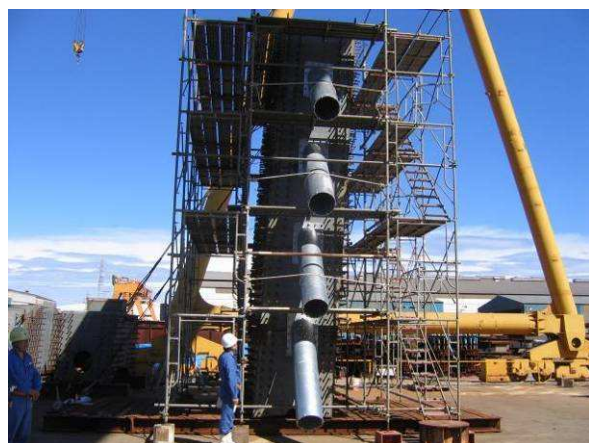
写真－4 鋼殻仮組立状況
