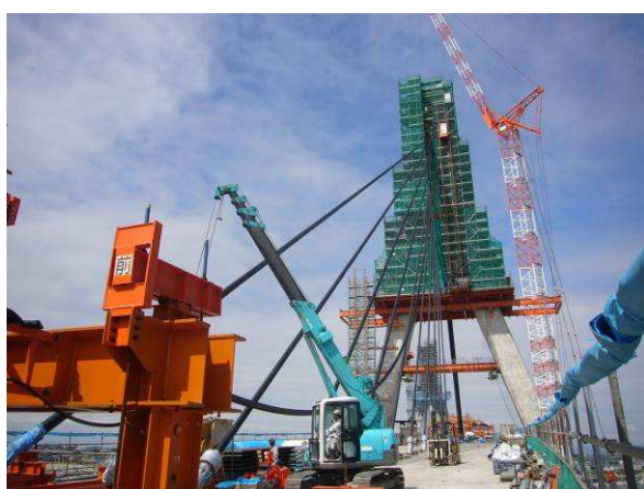
写真－10 斜材の架設状況（主桁側）
