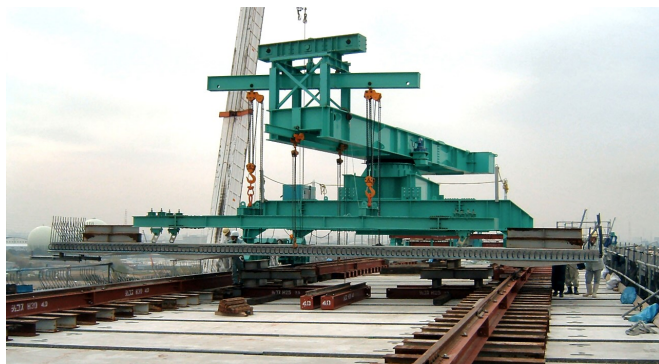
写真－2 橋上架設機
