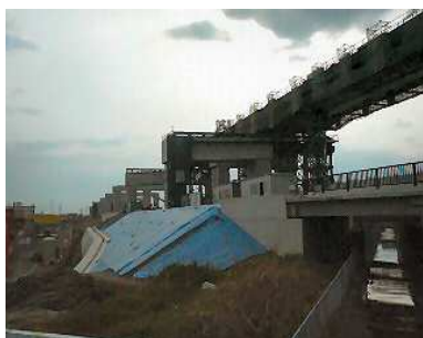
写真-1 施工前写真 (全景)
