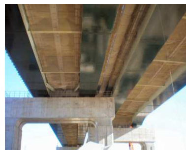
写真-2 施工中写真 (主桁下面)
