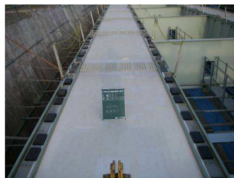
写真-6 ゴム板敷設状況
