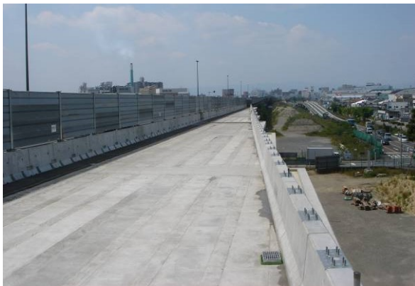
写真-1 完成写真（拡幅終点側より撮影）
