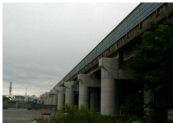
写真-1 施工前の現場状況（P44 橋脚より）
