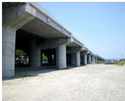
写真-13 完成後 (P51 より)
