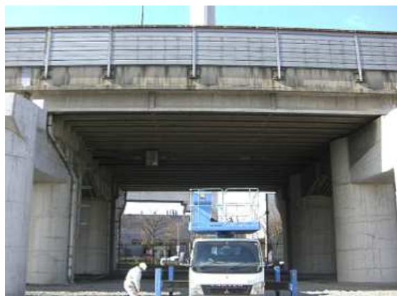
写真－2 調査状況
