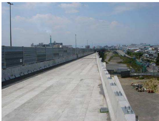
写真-12 完成後 (P52 より)
