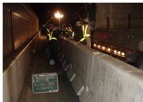
写真-9 架設防護柵設置
