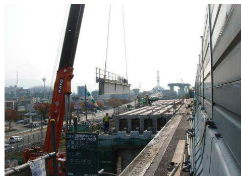
写真-10 桁架設
