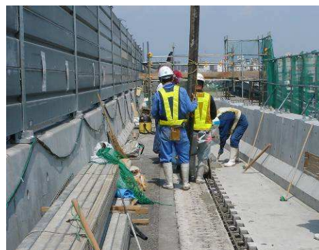
写真-11 接合部床版打設 (高流動コンクリート)
