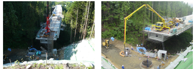
写真-1 施工状況
