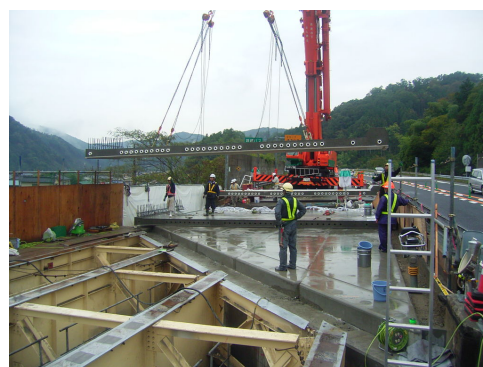
写真-2 延長床版の架設状況
