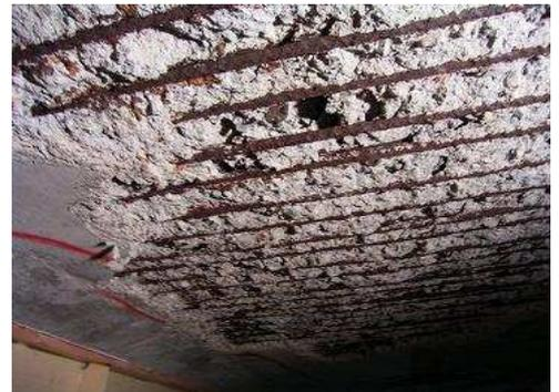
写真-2 床版下面の劣化状況
