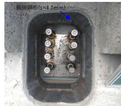
写真-5 箱抜き部の補強
