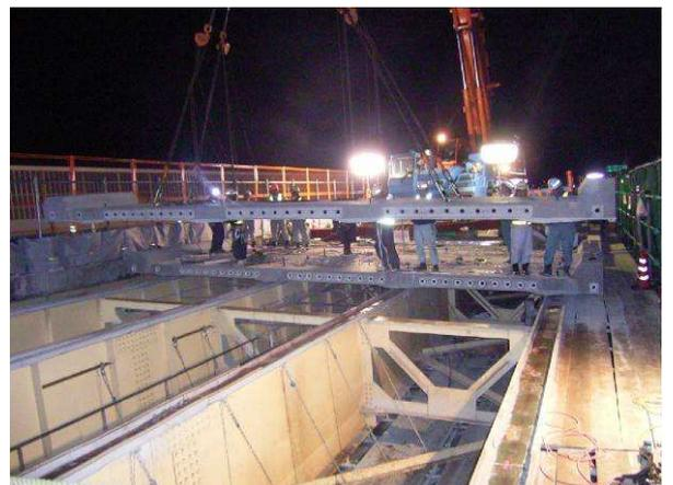
写真-3 プレキャストPC床版の架設状況
