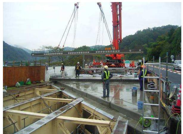
写真-6 延長床版の架設状況
