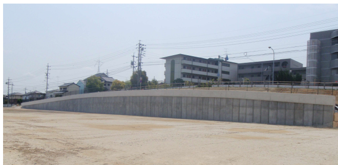
写真-1 完成写真
