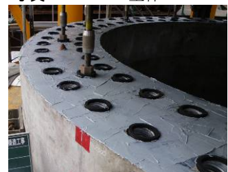
写真-4 止水パッキン設置
