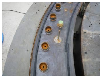
写真-1 刃口金物
