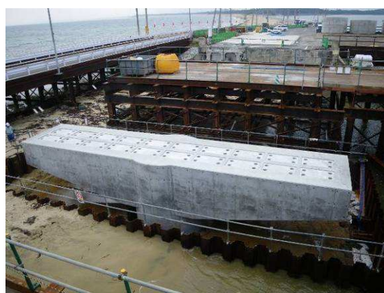
写真-17 橋脚工完了
