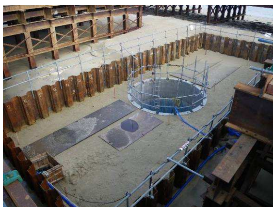
写真-16 PCウェル完了
