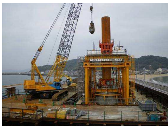
写真-8 拡翼掘削状況
