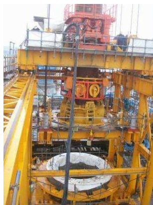
写真-8 拡翼掘削状況
