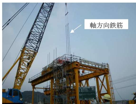
写真-10 軸方向鉄筋挿入
