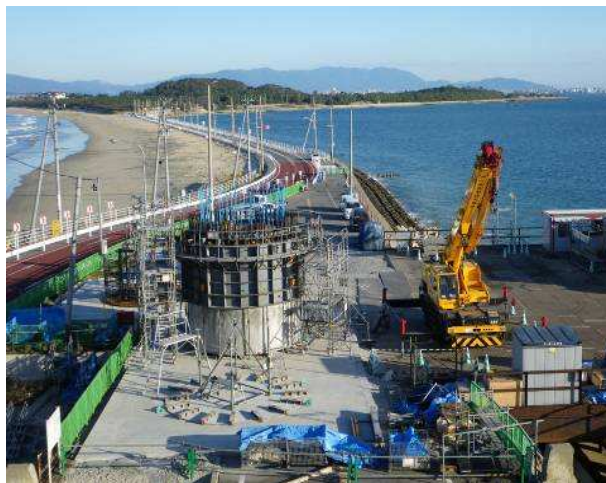
写真-1 単体ブロック製作ヤード
