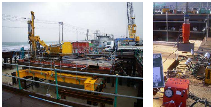
写真-6 グラウンドアンカー施工状況
