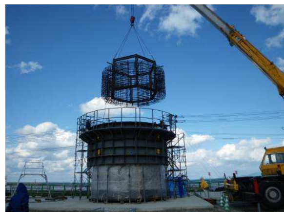
写真-2 鉄筋籠吊り込み状況
