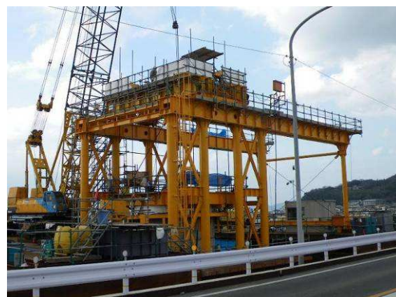
写真-5 PSM式支持圧入装置
