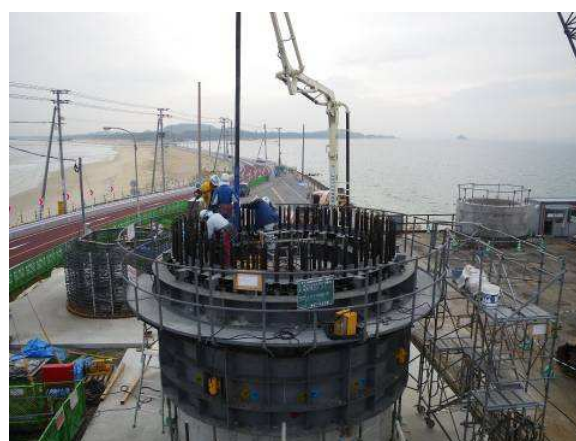
写真-3 コンクリート打設状況
