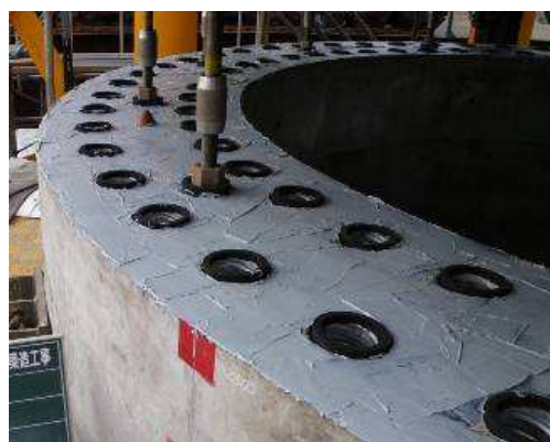
写真－14 止水パッキン設置
