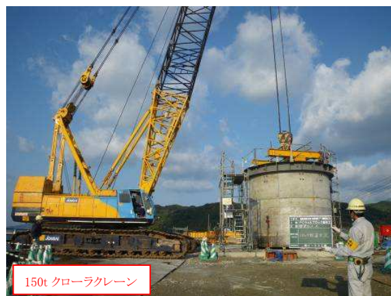
写真-4 単体ブロック転置状況
