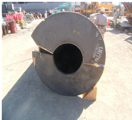
写真-1 つばさ杭先端翼
