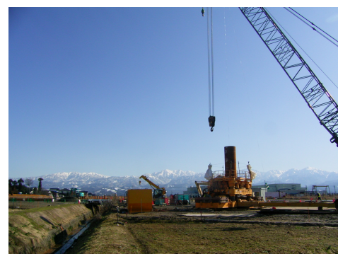
写真-2 施工状況
