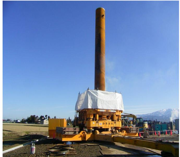
写真-5 鋼管回転圧入状況
