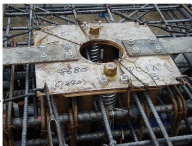
写真-3 アンカーセット完了状況
