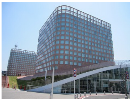
写真-1 建物外観
