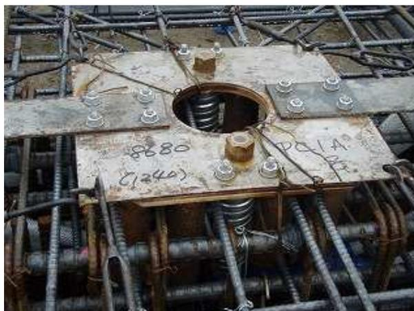
写真-6 アンカーセット完了状況
