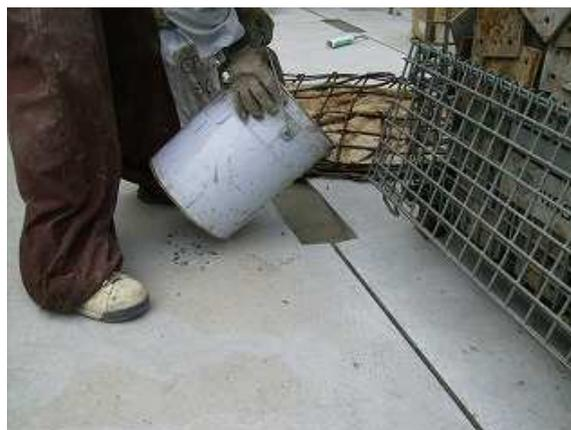
写真-20 ST版目地打設状況
