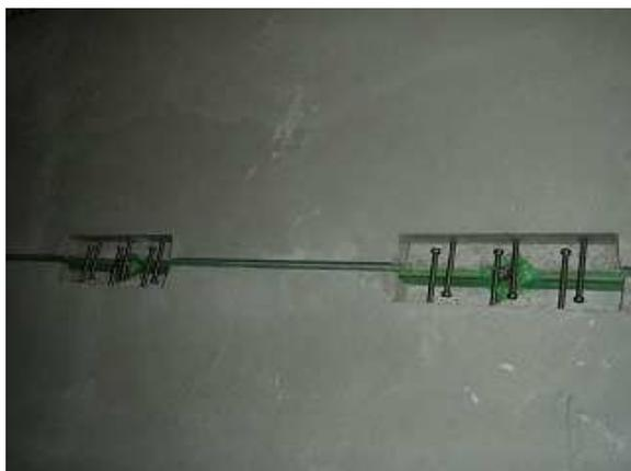
写真-19 ST版目地打設前状況
