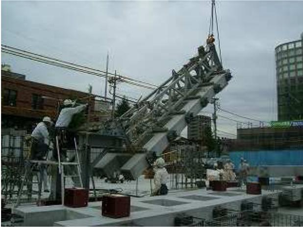
写真-9 外周フレーム部材建て起こし状況 (建て起こし治具使用)
