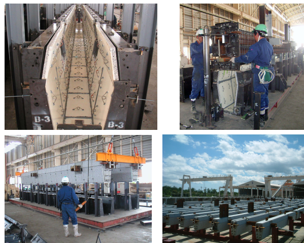
写真-4 製作状況
