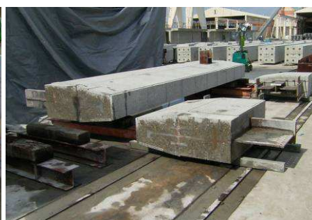
切断による梁接合部充填確認
