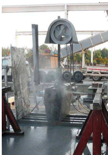
写真-3 切断状況
