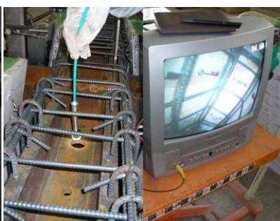
CCDによる型枠内部確認
