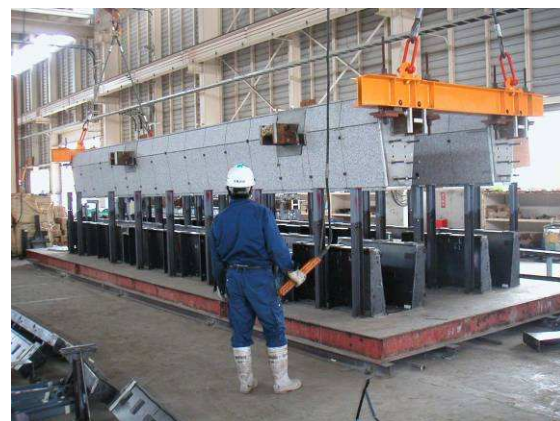
写真-15 取り出し状況
