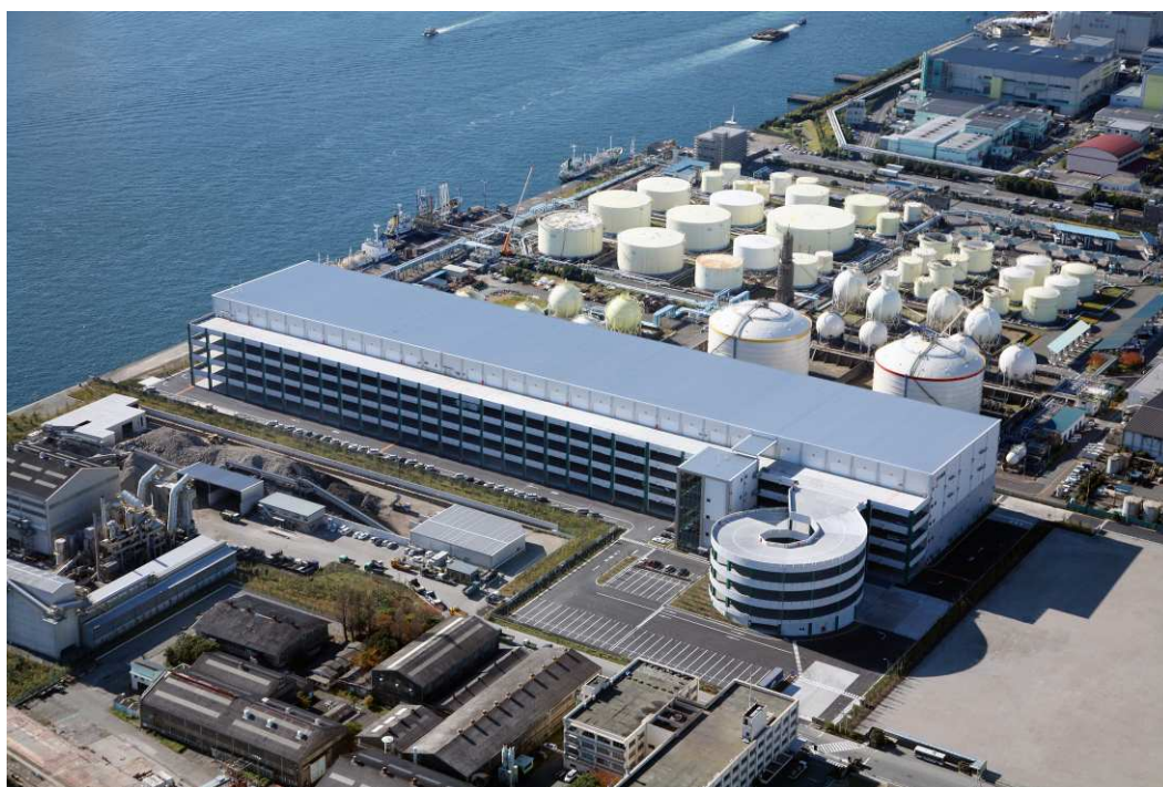
写真－1 建物外観
