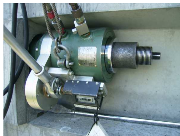
写真-4 900kN PC 鋼棒ジャッキ
