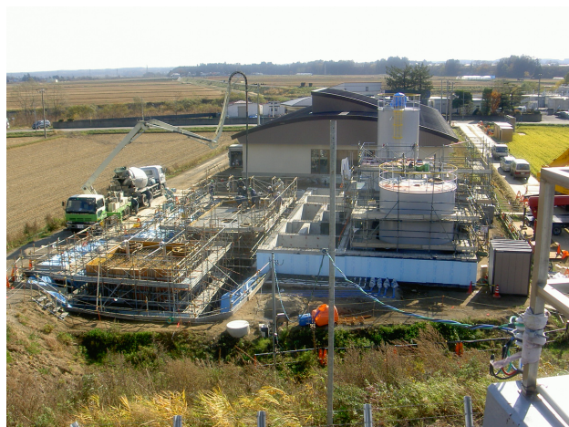
写真-4 消石灰注入設備施工状況
