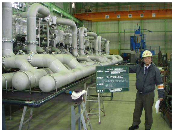
写真-2 工場での膜ろ過設備組立状況
