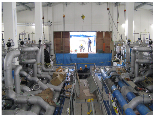
写真-3 現場での膜ろ過設備再組立状況
